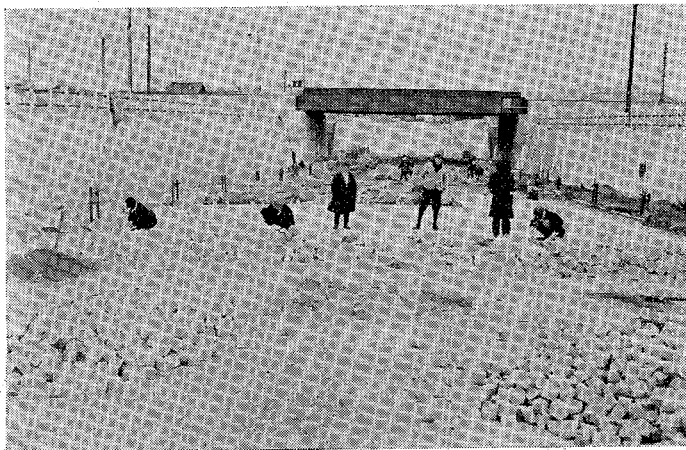
豐橋市八町通り (小鋪石) 鋪裝工事狀況
