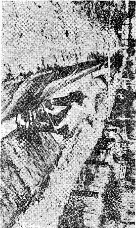
第 4 圖 水路の上塗り仕上げ作業角シヨベルを以て軽く叩きつゝ V 型水路の側壁を平坦に仕上げ。
