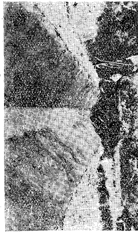
第 6 圖 龜裂は側壁の一部より削りたる材料を以て填充したる後の仕上り状態。
