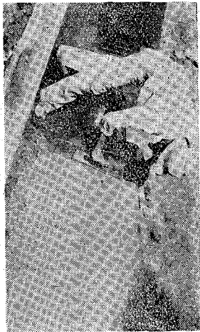
第6圖 前日施工したる部分と當日施工したる新舊の接手は入念に鍍を以て仕上げる必要がある。
