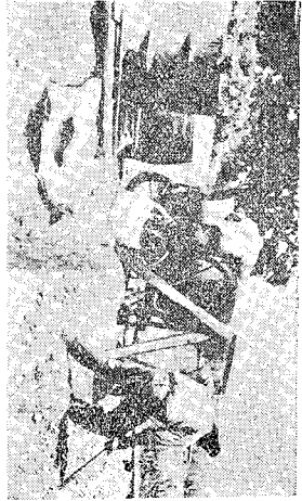
第 1 圖 後方にあるは小型混練土 ミキサーを示し「ピテューマス」と骨材（土壌を）との混合作業をなす。
