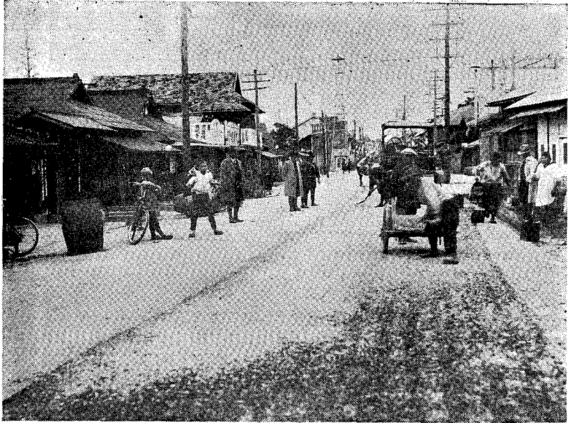
栃木縣氏家鋪裝工事 昭和九年三月施工
