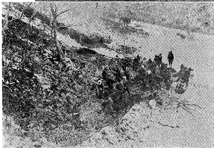
後志管内 磯谷村地内 準地方費道江差岩内線外一線改良工事 婦女の上敷用碎石作業
