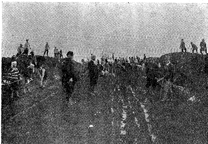
後志管内 狩太村地内 町村道狩太岩内線改良工事 路盤及側溝の仕上作業
