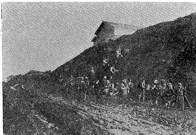
後志管内 歌葉村美谷地内 準地方道江差岩内線改良工事 婦女の土石運搬作業
