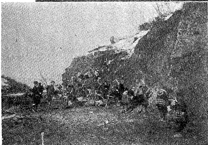
後志管内 南尻別村地内 町村道蘭越新見温泉間改良工事 切取作業
