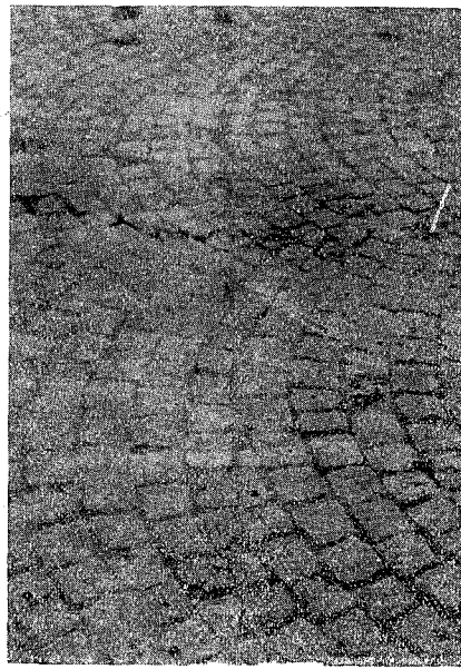
小鋪石の直線目地
