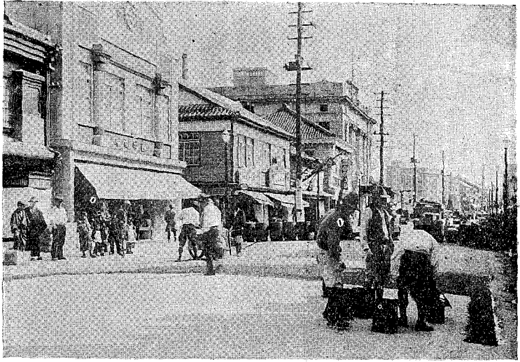
宮崎市橋通鋪裝工事
