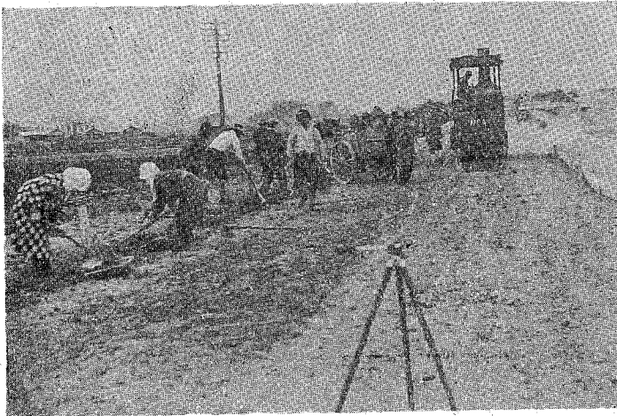
第三圖 路盤工
