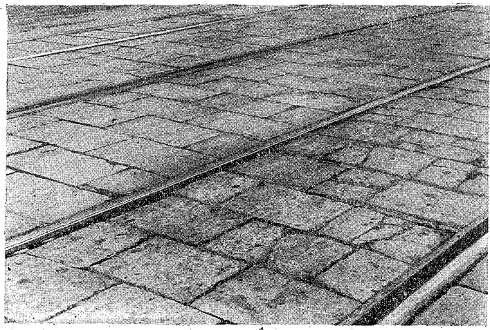
「クツロブ・ト」なるたれらせ壊破りよに車動自 (近附道車馬)
