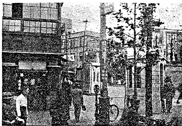
(るえ見に後の箱話電)箱壓變、話電衆公、番交の上道歩
