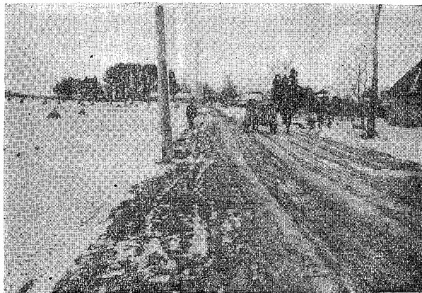
第四圖 青森五號國道國庫補助水締砂利道區間
