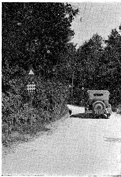
具のサーベルの様にまげられて終るものさへあり、又路傍に建てたものとして美觀と云ふ點をも考慮せねばならぬ。故に美にして堅を目的として柱を外徑五纏、長三・〇三米の瓦斯パイプに改め、取付は總て電氣熔接としパイプ
