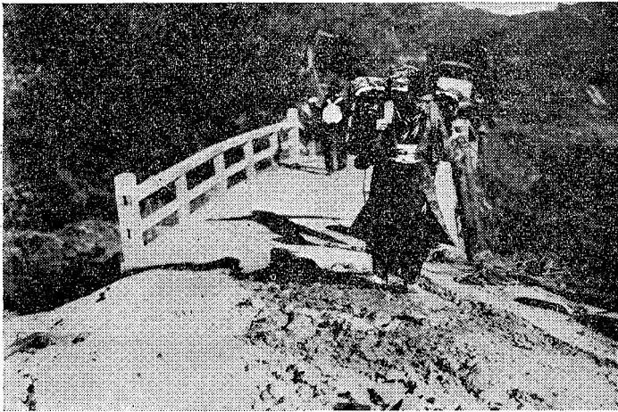
部一の所箇壞崩八村見大中線仁大東伊道縣府(圖八十二第)
