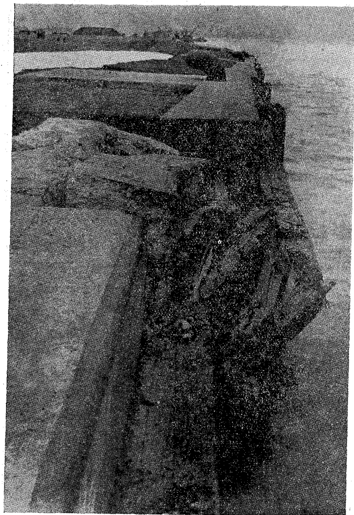
所箇壊破壁岸噸千八港水清 (圖五十四第)
