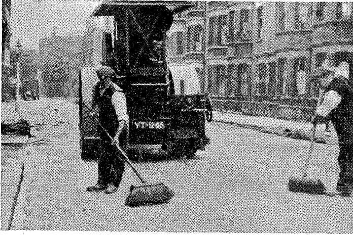
。ろす縮減でまるす出滲に面表がタルモし壓機で以をラーロムダカマ
