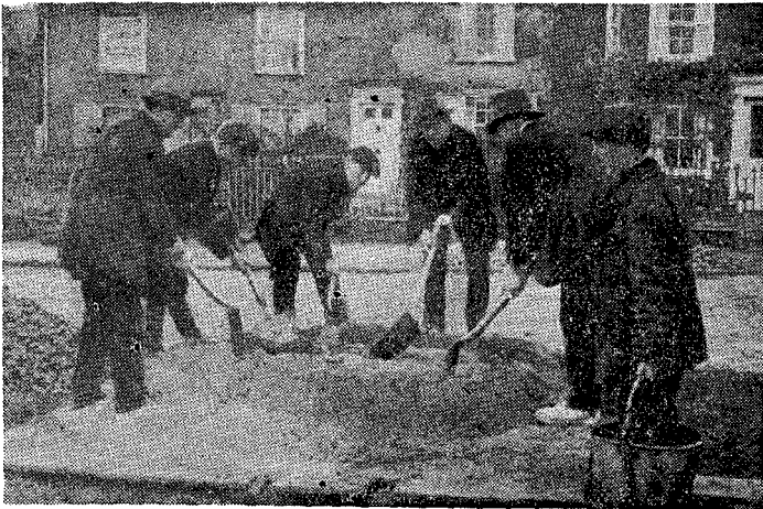
配合の 2:1 合配のセメントタルタル練で混合する。 (英失業者救濟事業の勞働者注意)
