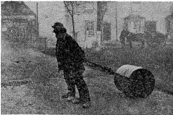
間時二でま上仕りよ手着。るげ上仕に滑平を面表りよにラーロトシハ。いならなばれけなし了内に以
