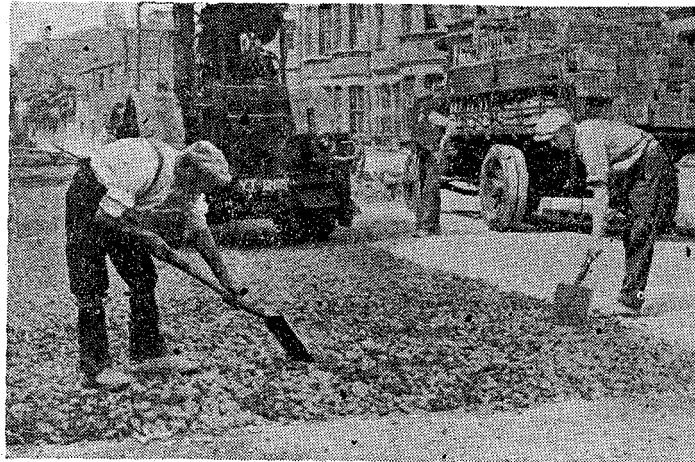
路盤上を大に二寸以下に石碎の下に三寸厚に敷き均しガマシロムを以て 輾壓する。
