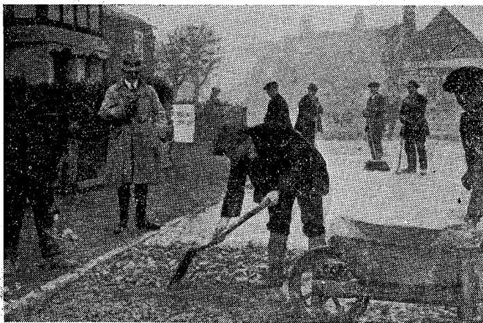
。吋三き厚の層、下以吋二き大の石。布撒の石碎層上
