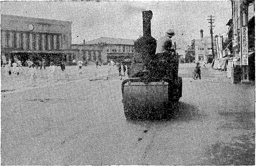
岡山驛前廣場ニ於ケル當組シートアスファルト舗設作業
