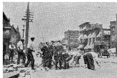
石塊鋪裝の補修ファイラデルフォイヤ所見
