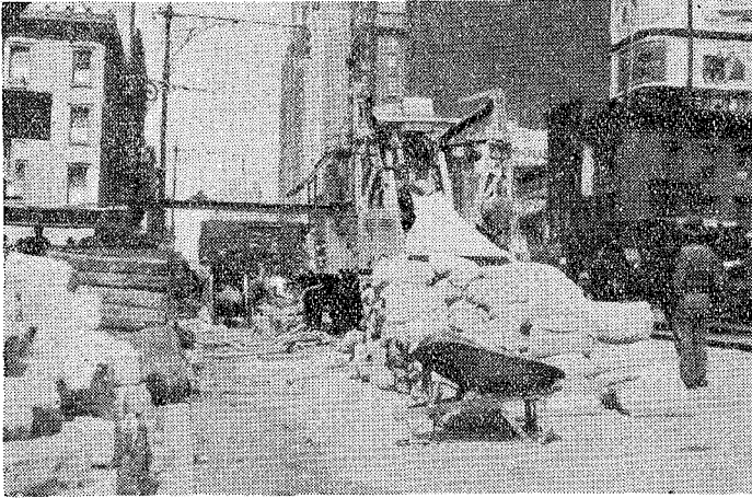
石塊舗装をアスファルトコンクリートに改造中、シジクス、アベニュー所見
