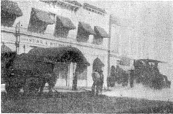
良改装舗のトーリトスドーサ港桑 圖六十第 (處るす熟加を装舗葛がーターヒドーロに煙白の面路手右)
