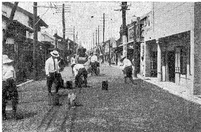
川崎市内道路裝飾工事「ビチュウマルス」注入の情況
