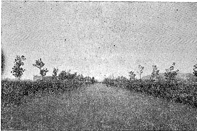
京濱國道舗装完成の情況
