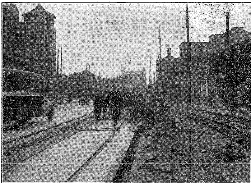
大阪東區北濱電車軌道ソデッチト舗装工事狀況
