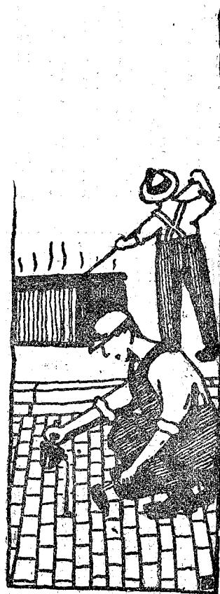
設して在る、歩車道の區別もあれば美事なる珠造りにしたるアカシヤ及傘形に刈り込んだラタヌスの並樹が繁茂して道路を美術化して居る、路面は二十珊乃至二十五珊の厚さに花崗岩の碎石を以て仕上げ、表面の目潰し材料としては花崗石の腐蝕した真砂土を使用し、十五屯乃至十屯の蒸氣ローラを以て水締めマカダムを築造して居る。青島が吾々の手に歸してからも此の工法を踏襲した、表面の目潰し材料は岩石を破碎して造つた石屑よりも水締めの際粘着性を帶びて居る爲に路面が早く平滑に仕上られ、且つ竣工後は幾分固結性を帶び路面を結合するに好都合である、内地でも中國筋、東海道筋には此の材料は豊富な筈であるから使用されたならば良好なる路面を構成さるゝであらう。
