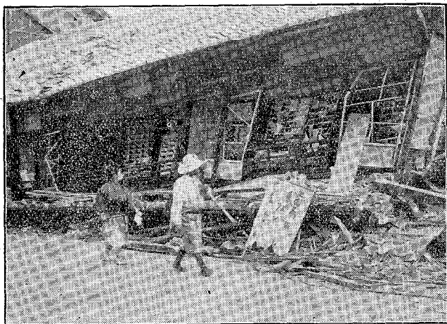
豊岡停車場前通過の倒壊家屋
