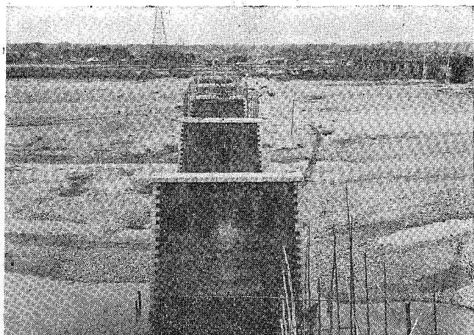
左岸橋臺上ヨリ全工工程ヲ望ム
