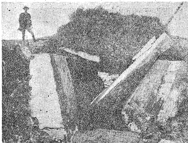
取付道内溝橋破損の狀況
