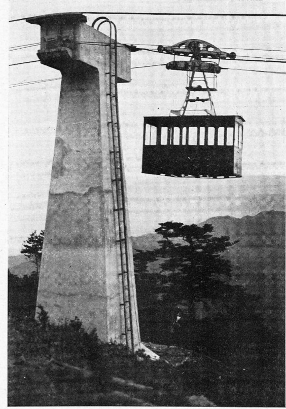
京都電燈株式會社叡山空中ケーブル釣瓶式運轉多線式旅客用索道 (巨長 641.69 米, 最大徑間 409.05 米, 海拔 710 米, 支柱高さ 12 米, 搬器定員 20 名, 速さ毎秒 3 米)
