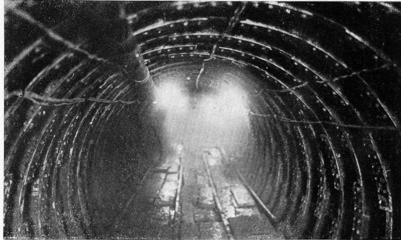
熱海口水抜坑に於ける 鉄製セグメント覆工 →
