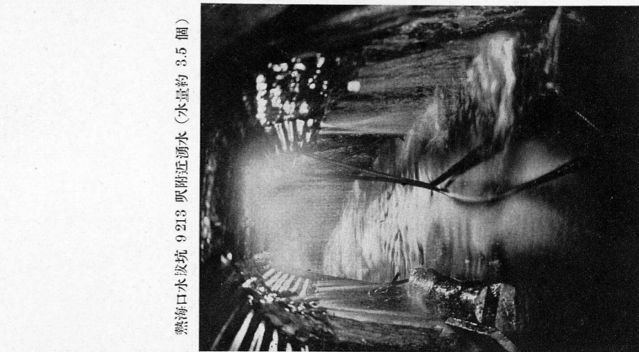
熱海口導坑 9 180 呎附近セメント高壓注入箇所にてける試維坑の湧水 (水量約 4 個)
