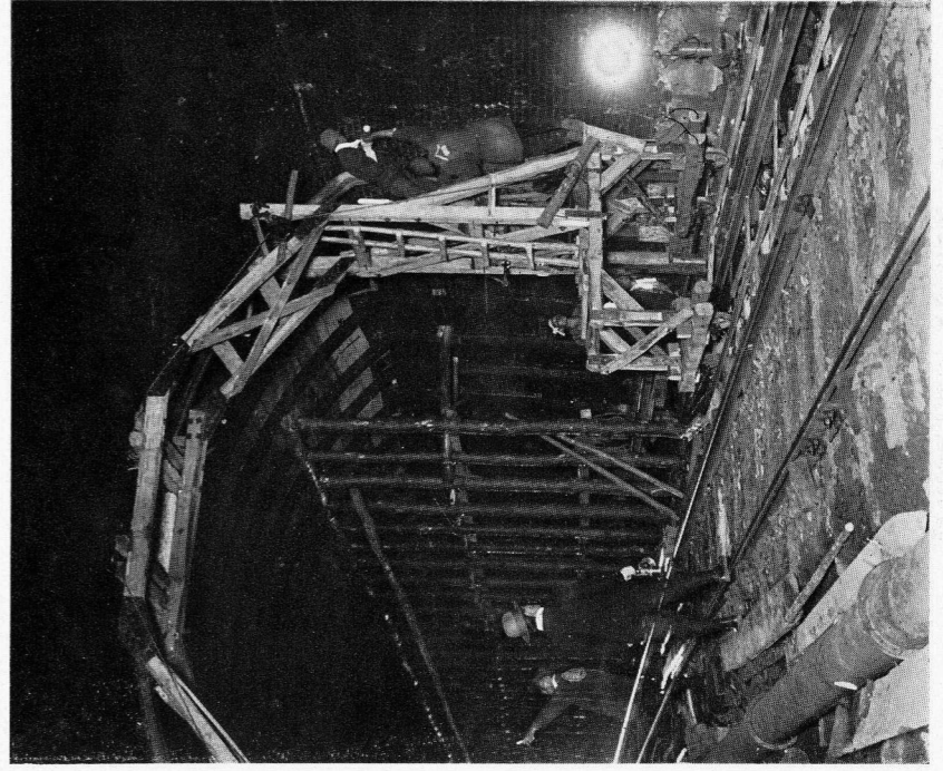
在來隧道補強掛架支保工組立
