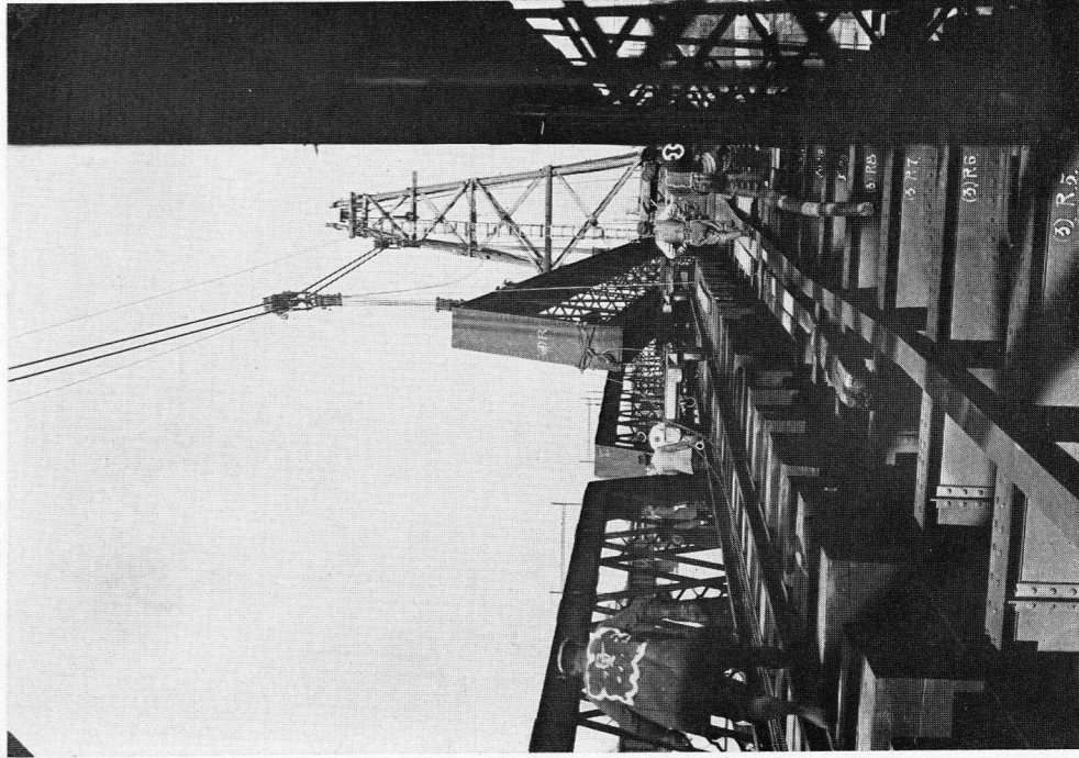
舊橋梁 100 呎構桁撤去 複線式 100 呎構桁の撤去状況、兩岸に水面上 80 呎の鐵塔を建て、塔に 2 條の鋼索條を張架し、之に 2 組の滑車及ブロックを用ひ、之に構桁（重量約 27 噸）を吊り、後方に引出し軌道上に豫め用意せるトロロリー上にとり撤去するものなり
