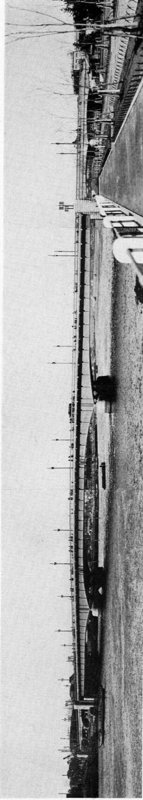
橋型 中央吊桁附鋼鉸突桁 3 徑間, 兩岸に連續鋼鉸桁 3 徑間, 橋長 237.7 米, 有効幅員 22 米
