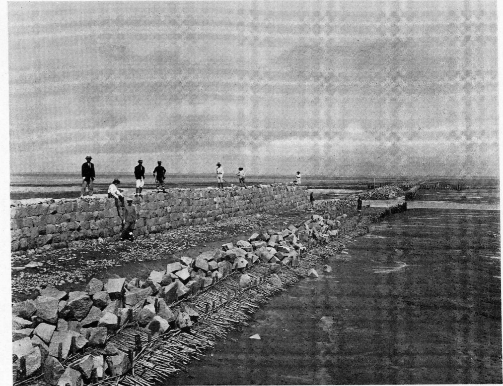
堤防の築造には天然泥土面に敷砂，敷粗朶を施し梯子土臺の上に石垣を積み上げ後方は盛土，前面に捨石を施す
