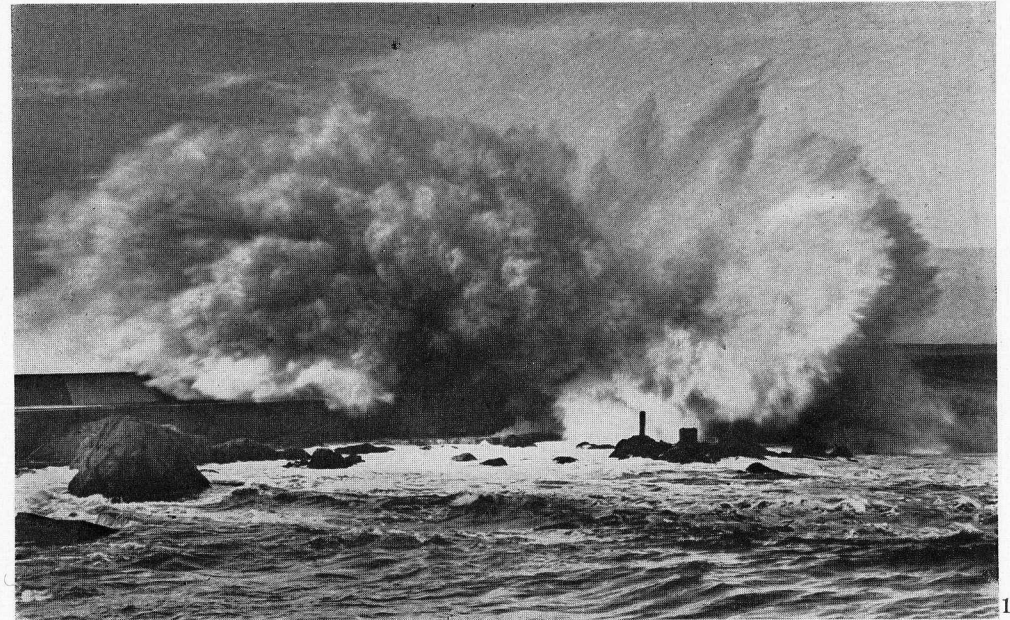
波浪の高さ 20 尺, 波長 360 尺, 週期 15 秒 防波堤は重量 各 23 噸のコンクリート塊を積みて厚さ 21 尺に造られしものなり
