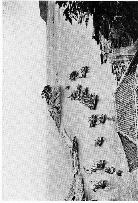
防波堤延長 79 間, 天端幅 3 間, 高さ 低水面上 7 尺
