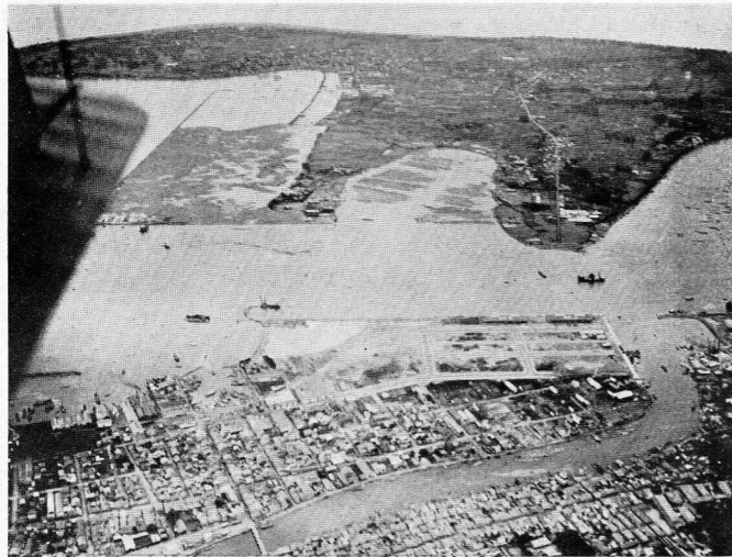
上空より見たる築港工事中の清水港 → 巴川河口の左方に見ゆるは水深 7.3 米, 8.5 米及 10.6 米の岸壁, 上方左は貝島埋立地なり
