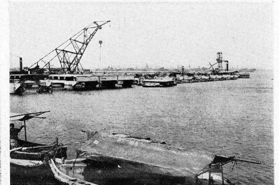
水深7.3米、延長135.5米、幅員25米、基礎杭打地、橋脚ブレード・シリンダー、上部は主としてプレカスト・スラブ使用
