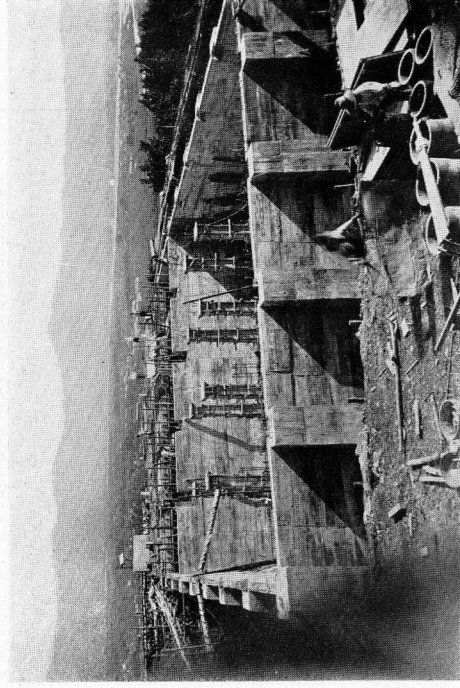
配水池導流壁の一部鉄筋コンクリート柱の築造を終り被覆鉄筋コンクリート型枠組立中
