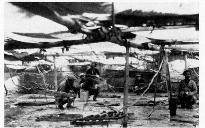
堰堤コンクリート保温の景
