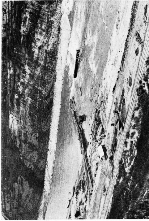
第二床固堰堤右岸假締切工事
