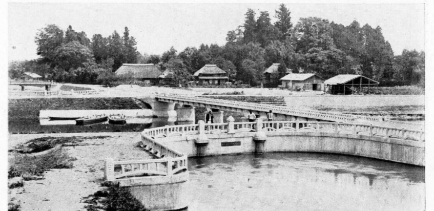
埼玉縣柴山伏越→ 柴山伏越吐口より呑口の方を望む、橋梁を架設せるは元荒川なり
