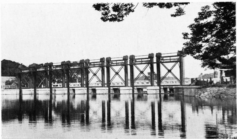
←埼玉縣古利根樋 埼玉縣南埼玉郡増林村古利根川筋、灌漑段別7600町歩、用水堰上高11尺、計畫最大通水量2500立方尺、通水幅10尺のストウニー式檜製扉8連にして捲揚高11尺、所要時間1人掛にて約7分
