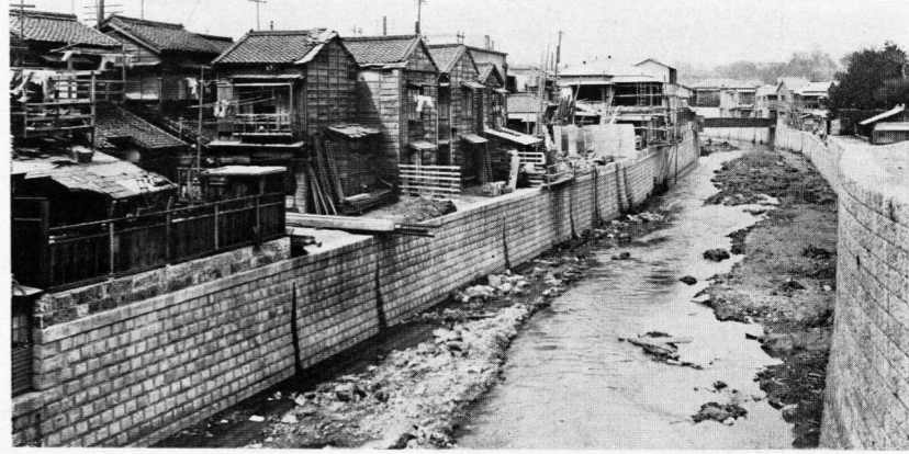
東京市古川改修工事竣工の状況 現在河底より尙1.5米以上 浚渫の豫定
