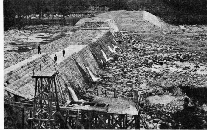
阿武隈川改修工事 支流荒川上流堰堤 地藏原堰堤 長さ 67.8 間, 高さ基礎面 上最高部 18 尺, 最低部 8.4 尺, 敷幅 23 尺, 土堤坪長さ 66.5 間, 高さ 18 尺, 天端幅 19 間
