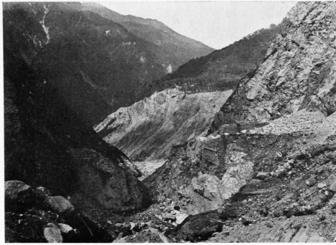
← 立山砂防 白岩堰堤工事設置豫定箇所附近
