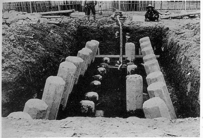
拱脚基礎混泥土杭打立終了
