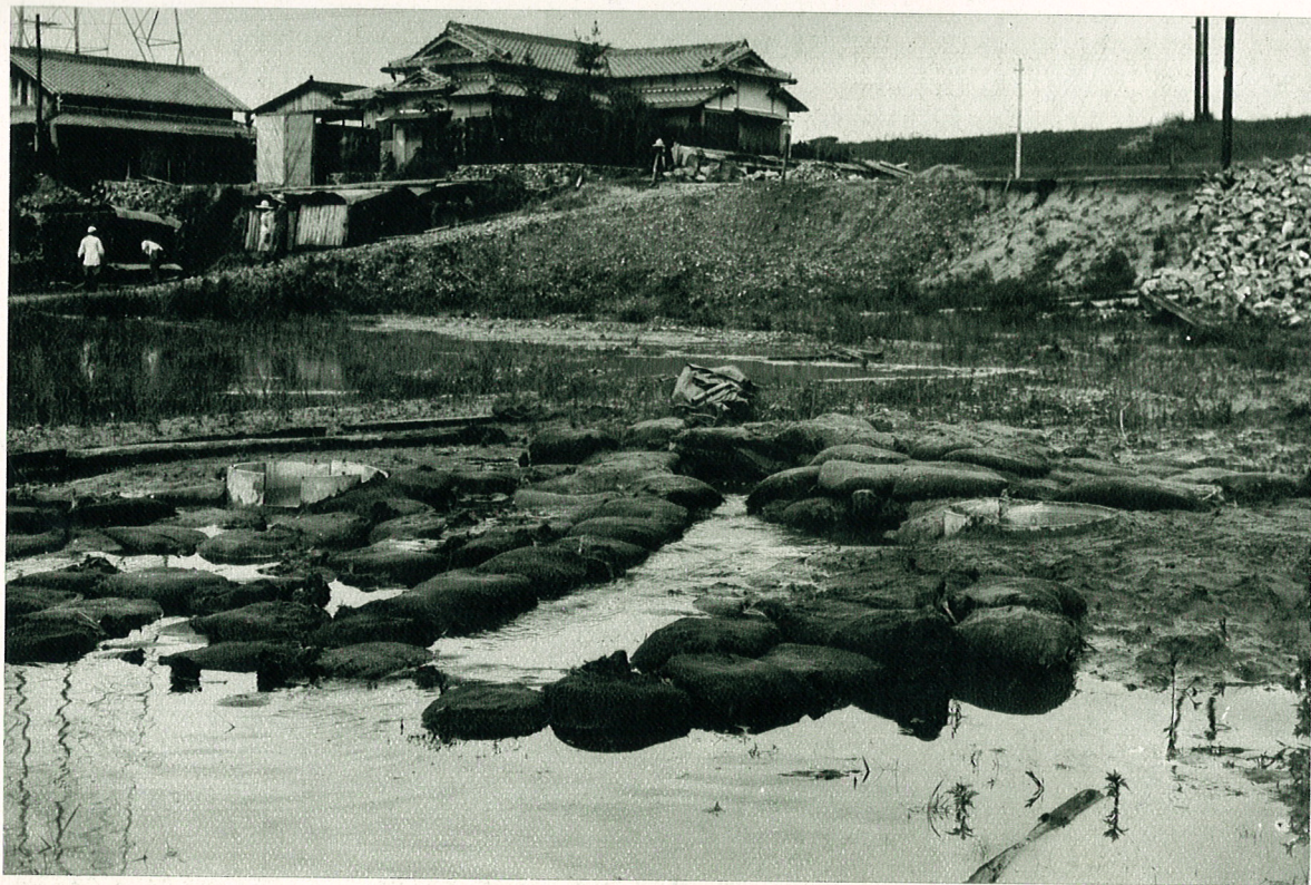
枚方町對岸大塚地内堤防法先漏水ノ狀況 (昭和十三年七月五日出水時)
