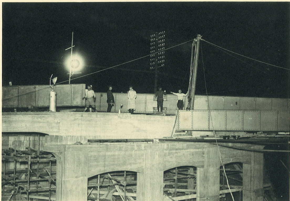
林崎跨線橋架設夜間作業狀況
