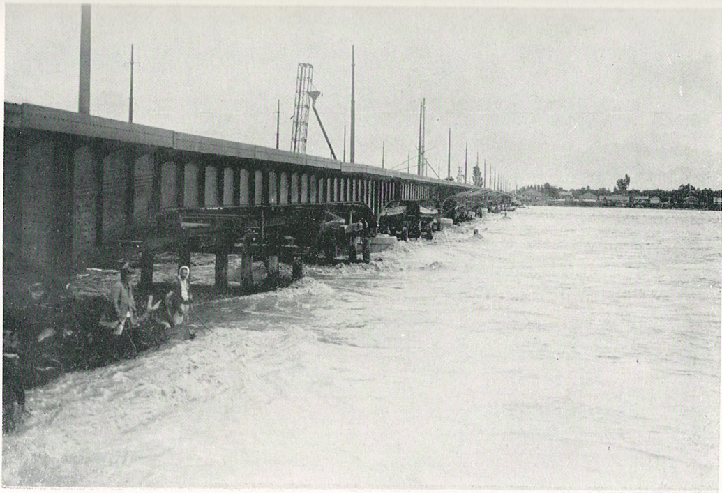
神通川出水状況 富山市鶴島地先新大橋地點（最高水位ヨリ四十糎減ノ時） 其 三
