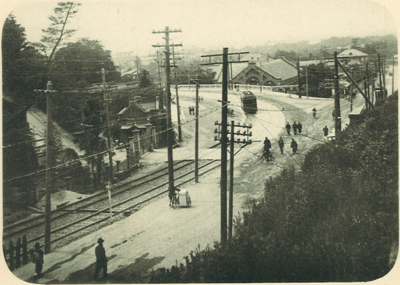
竣功セル國道二號線 京都市東山區三條通工事起点蹴上附近
