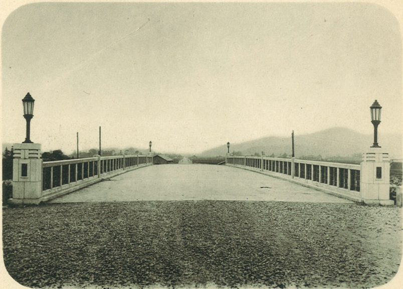
竣功セル國道二號線 撫川橋 岡山縣吉備郡撫川町地内
