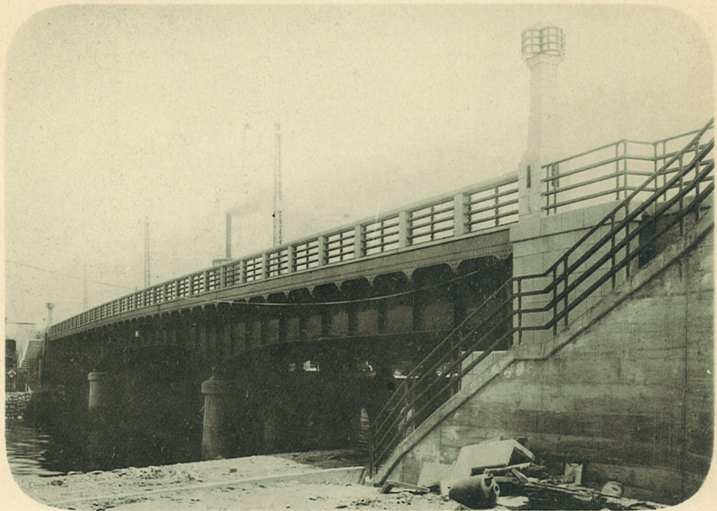
竣功セル國道十六號線 豎川橋 堺 市 内
