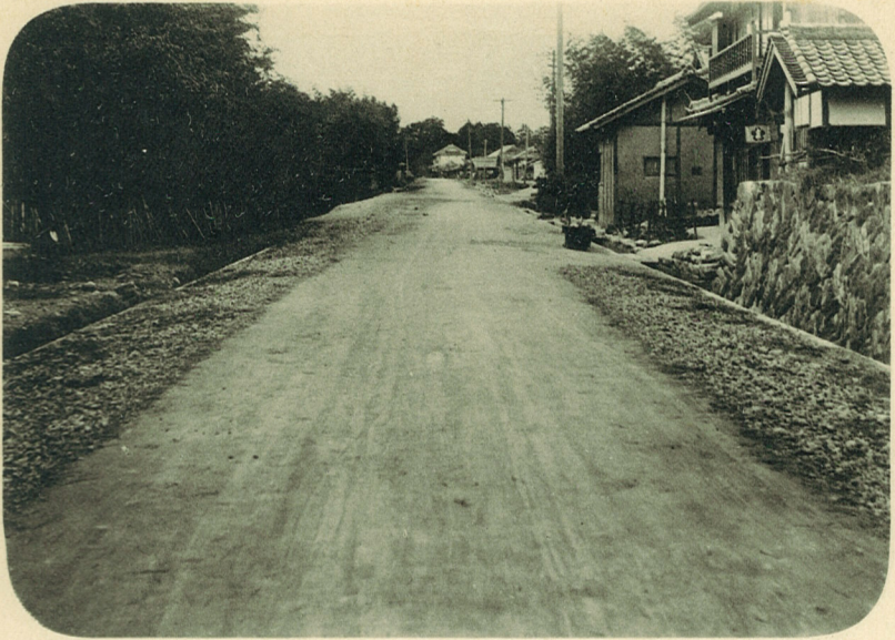
竣功セル國道十五號線 路床工事ノ一部 和歌山縣那賀郡田中村地内
