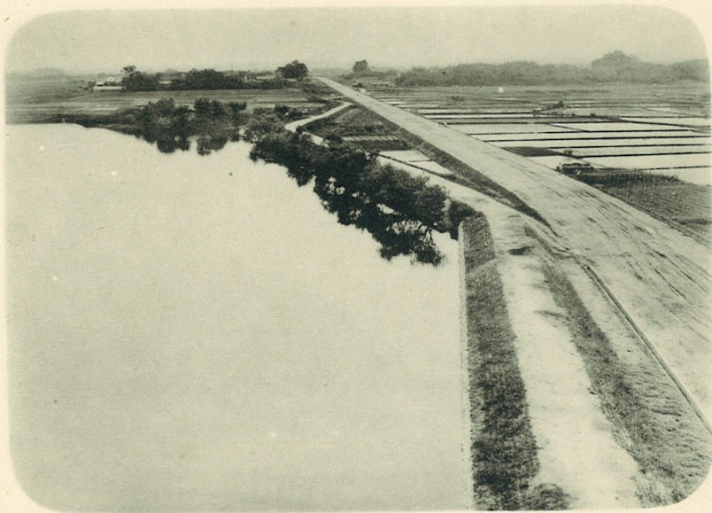
竣功セル國道十五號線 路床工事ノ一部 奈良縣添上郡明治村地内
