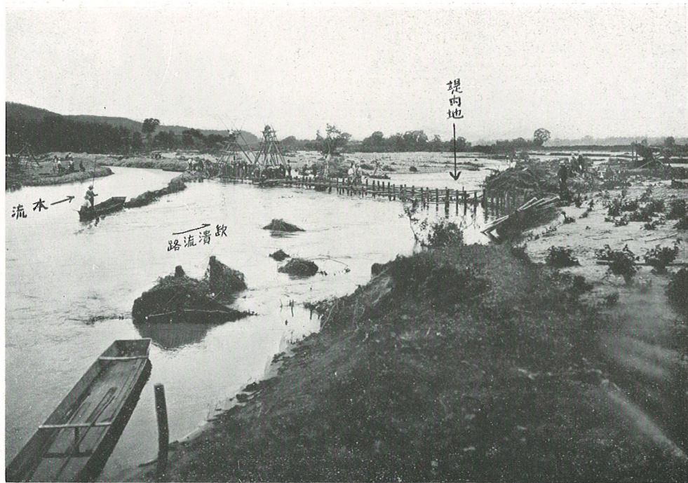
久慈川支川里筋佐都村破堤箇所
