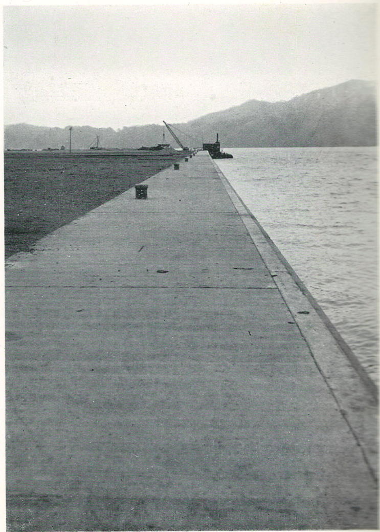
(1) 閉伊川左岸護岸工事(上流より河口を望む)
