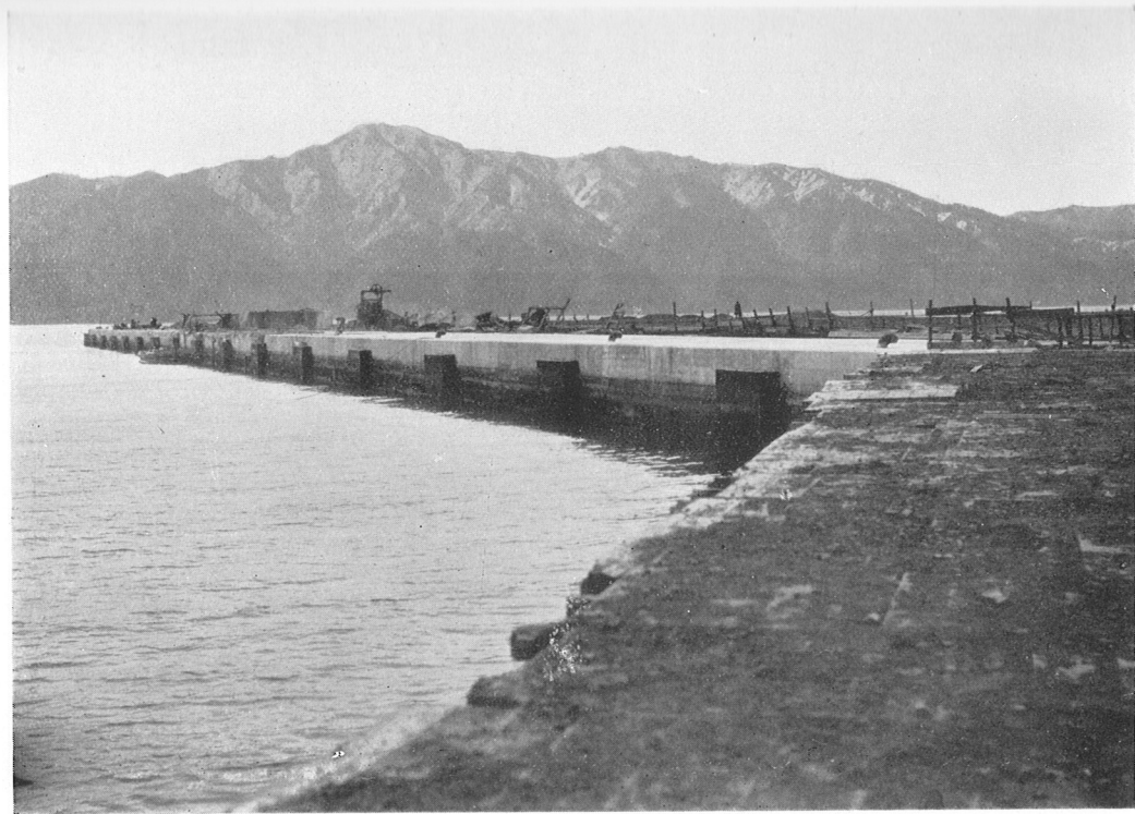
(2) 工 事 中 の 岸 壁
