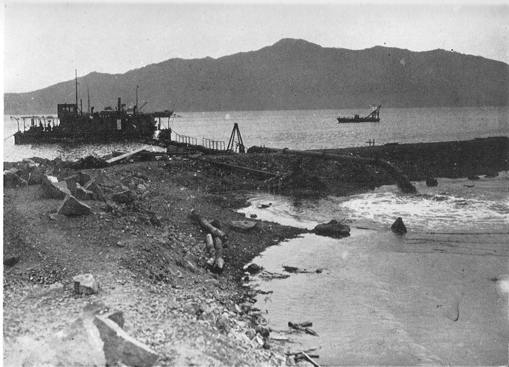
(6) ホンプ式浚渫船早池峯號にて埋立作業
