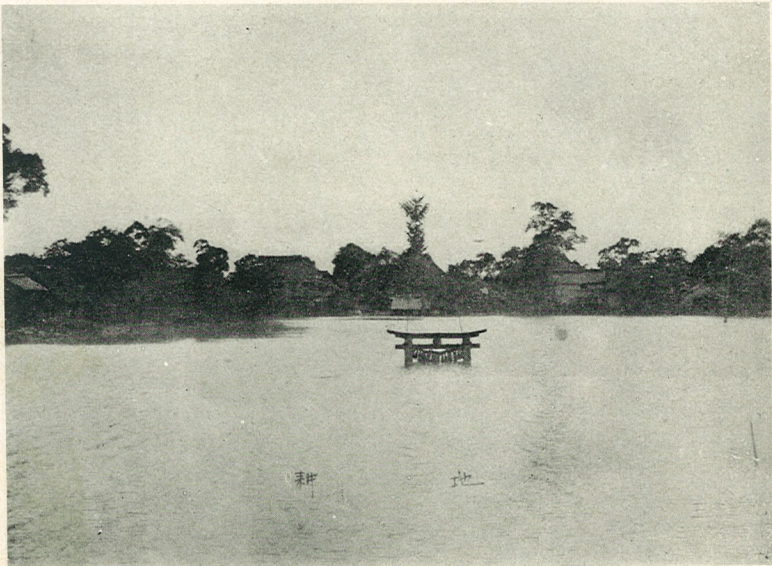
合組津中村寺善大リヨ = 潰決防堤川木荒内地村寺善大郡瀨三 (日一月七) 町七二積面害被 況狀ノ水浸區地全
