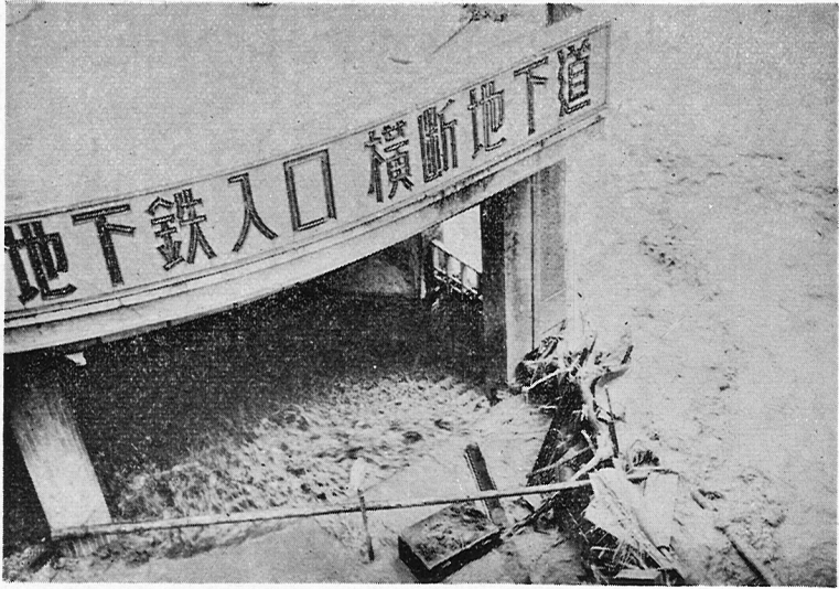
阪神電鐵地下道へ流れ込め濁流
